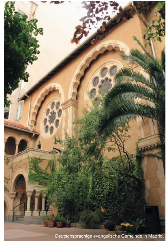
Bis 1939 Evangelische Kirche, wurde in der Franco-Zeit geschlossen; heute ein Mehrfamilienhaus.
